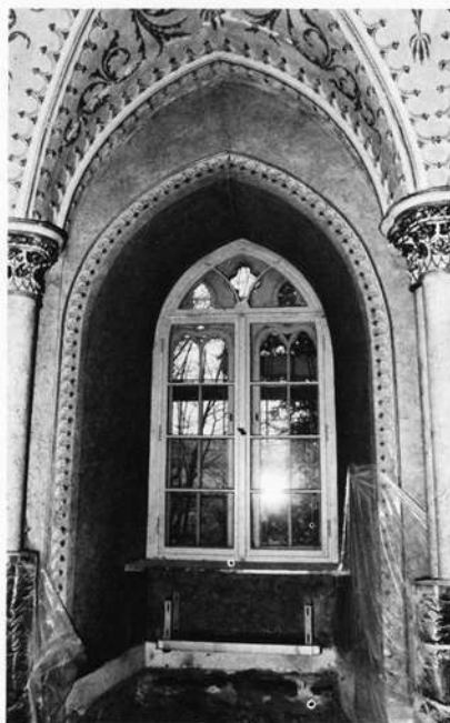
Während der Instandsetzung November 1985 Foto: Landbauamt Hof – Dienststelle Coburg
