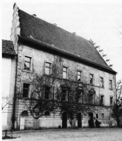
Amtshaus in Seßlach
