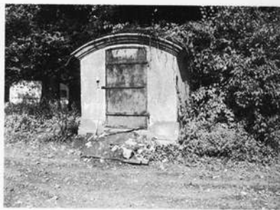
Rupprechtstegen (Gde. Hartenstein), Lampenbude im Bahnhofsgelände
