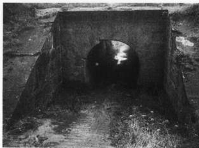
Sankt Veit (Markt Pleinfeld), Wegdurchlaß der Ludwig-Süd-Nord-Bahn. Foto: BLfD, Aug. 1985
