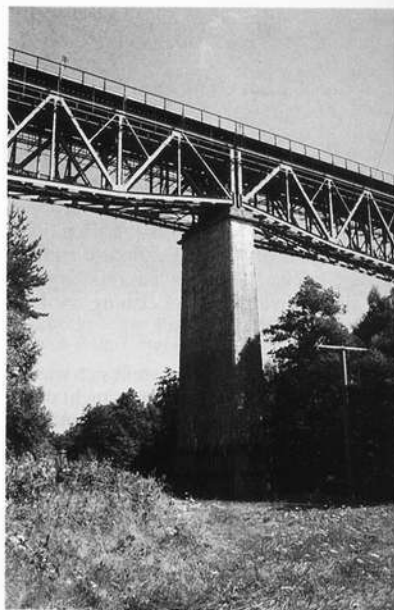
Neusorg, Viadukt über die Fichtelnaab der Fichtelgebirgsbahn Foto: BLfD, Aug. 1985
