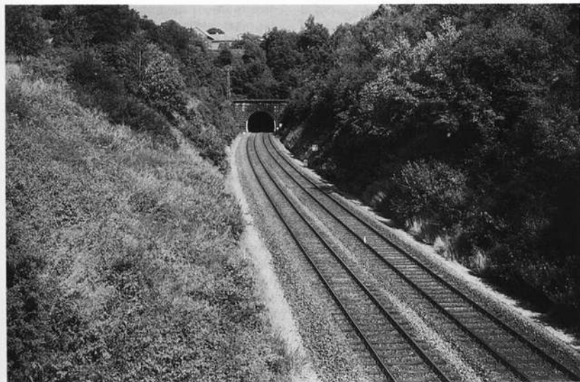
Oberwappenöst (Gde. Kulmain) Tunnel der Fichtelgebirgsbahn
