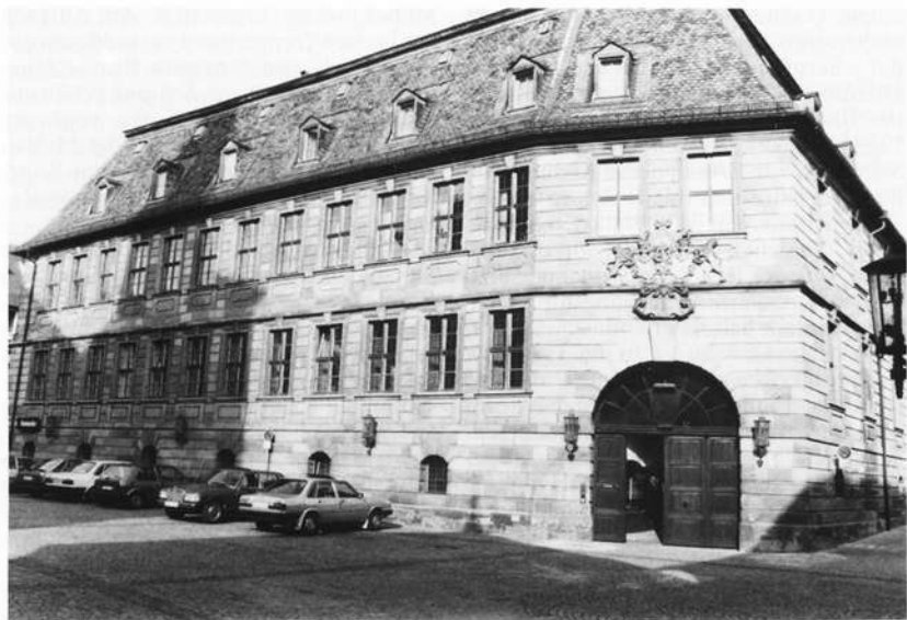
Blick auf Hauptpforte (Südost-Ecke)
