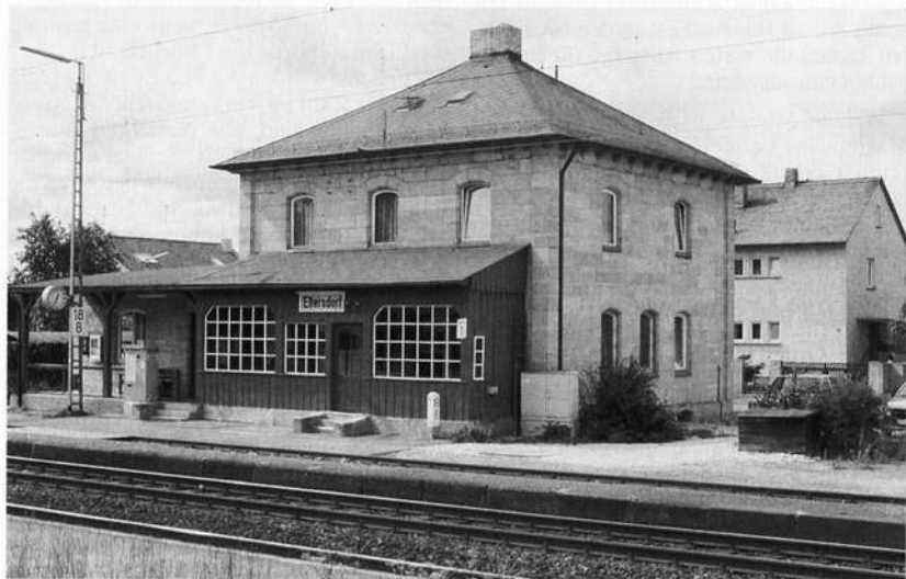
Zu den ältesten Bahnhöfen, die von der Bundesbahn in Bayern noch benützt werden, zählt Eltersdorf. Der 1845 fertiggestellte Bau ist bis auf kleinere Anbauten unverändert. Foto: Verfasserin
