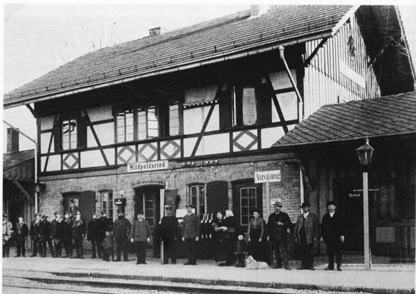
Fachwerkbauten wurden – in Annäherung an die örtliche Bautradition – nur im Allgäu errichtet. Die Aufnahme von 1902 zeigt die Station Wildpoldsried. Foto: Verkehrsmuseum Nürnberg
