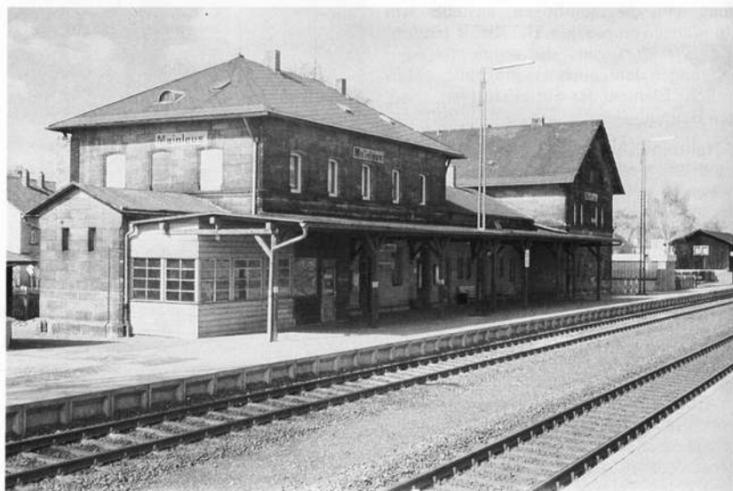
Weitestgehend unverändert erhalten ist der Bahnhof Mainleus mit seiner charakteristischen Bahnwärterkaserne (im Hintergrund). Er wird heute nicht mehr genutzt. Foto: Verfasserin
