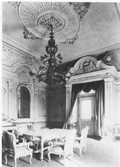
Bamberg; Ehemaliger "Königssalon" im Bahnhof. Foto: Lichtbildstelle der Bundesbahndirektion Nürnberg
