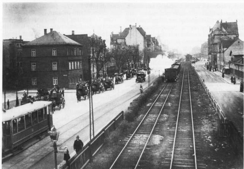
Nürnberg, Fürther Straße; Haltestelle Maximilianstraße. Links: alte Straßenbahntrasse parallel zur Ludwigsbahn. Foto: Bildstelle Hochbauamt Nürnberg
