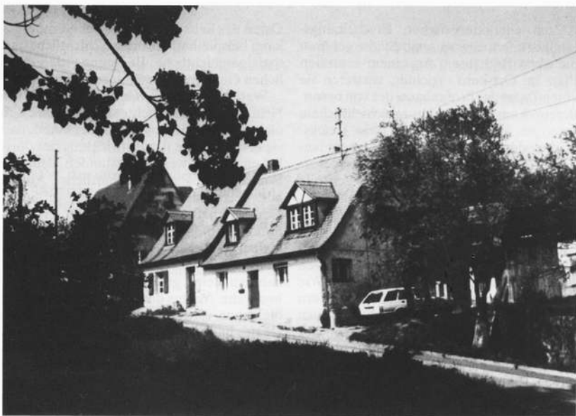
Gemeindehaus in Beerbach, bestehend aus dem ehemaligen Hirtenhaus und dem angebauten Armenhaus (links)
