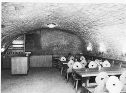
Gastraum im Kellergewölbe
