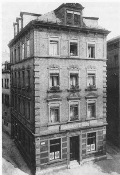
Das Betriebsgebäude um 1930 . . .
