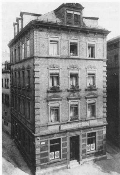
Das Betriebsgebäude um 1930 . . .
