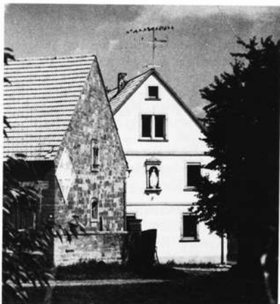
Weidenmühle bei Poppenhausen
