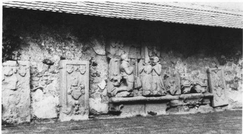
Die gegenwärtige Situation an der Friedhofsmauer, rechts die traurigen Reste des Aufbaus
