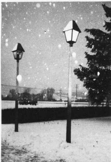
Die neuen Straßenleuchten des Fränkischen Überlandwerks. Bestückung: Glühlampe 200 Watt, Kristallglas (links), HQL 80 Watt oder NAV 70 Watt, Opalglas (rechts), (HQL = Quecksilberhochdruckdampfl. (Weißes Licht), NAV = Natriumdampflampe (Gelbes Licht))
