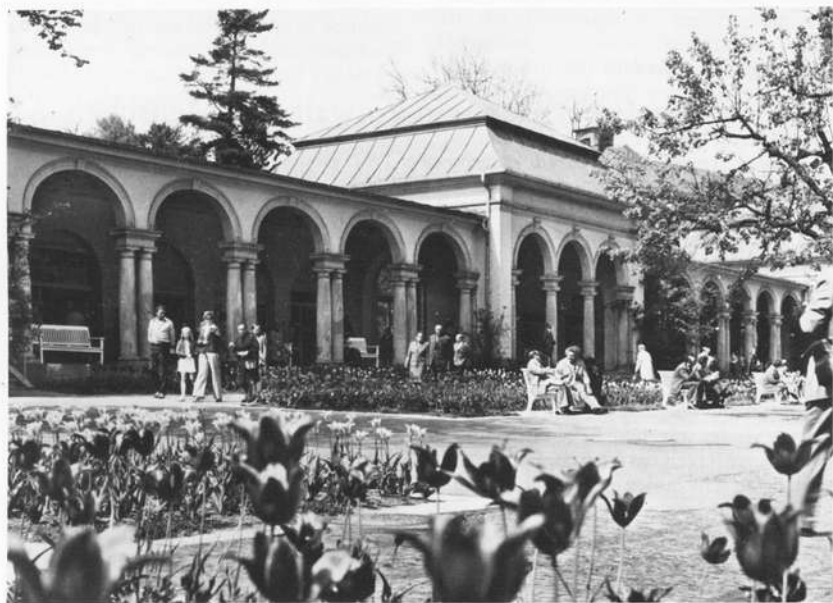
Kurplatz und offene Säulenwandelhalle in Bad Steben. Foto: Staatliche Kurverwaltung Bad Steben
