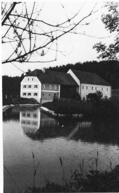
Spiegelglasschleife und Getreidemühle Baumhof, Rekonstruktion mit originaler Betriebseinrichtung, Antrieb über zwei unterschlächtige Wasserräder
