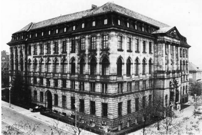
Museumsbau des Bayerischen Gewerbemuseums, erbaut 1892-1897. — Heute: Verwaltungsgebäude der Landesgewerbeanstalt Bayern — Gewerbemuseum im 2. Obergeschoß
