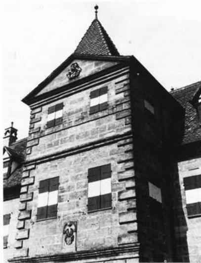
Blick auf den turmartigen Mittelbau des Hauptschlosses Neunhof
