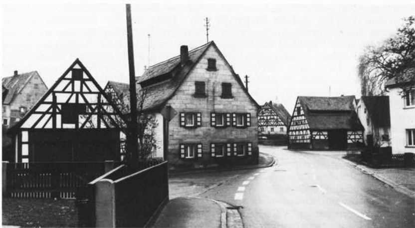
Fachwerkensemble in der Hauptstraße in Neunhof
