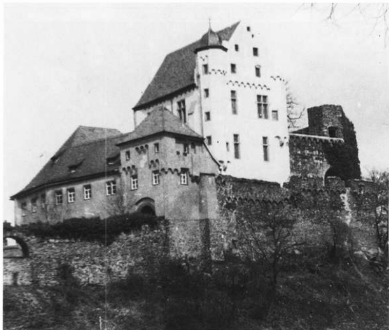
Burg Alzenau nach der Renovierung
