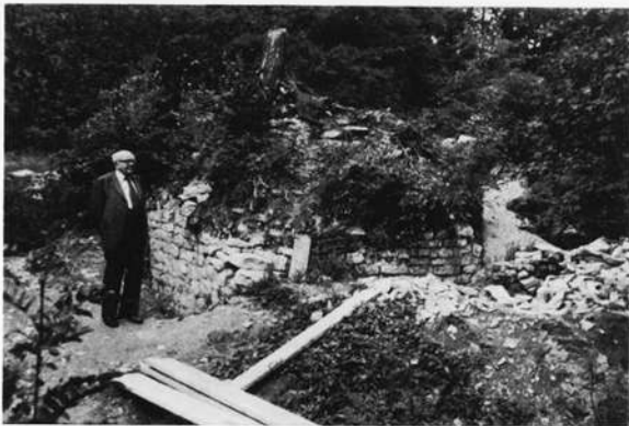
Turm (Bergfrit) mit freigelegter Süd- und Ost-Mauer (was eine großzügige Spende ermöglichte)
