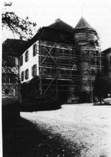
Schloß Pretzfeld während der Renovierung in den letzten Jahren
