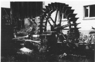
Mühlrad der Neumühle (als Schmalrad noch laufend)
