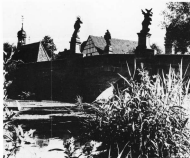
Die Bauschebriiche in Fritzensdorf
