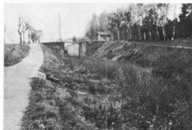
Kanalbett bereits mit Gras bewachsen, 1959 bei Forchheim Schleusenammer, heute abgetragen, B 407
