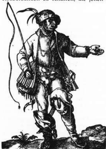
Der Frammersbacher Fuhrmann von 1577 (Holzschnitt von Jost Amman)
