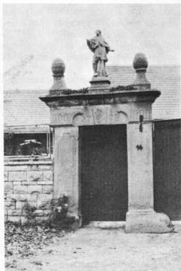
Bild 5 Gewänderahmenpforte in Düllstadt (1778)
