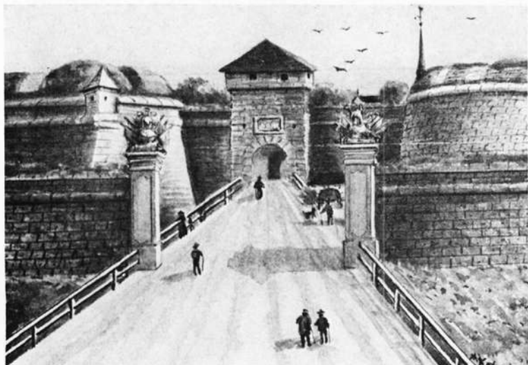
Zugang zum einstigen Bamberger Tor, 1557 errichtet, von Norden her. Es wurde 1881 abgebrochen
