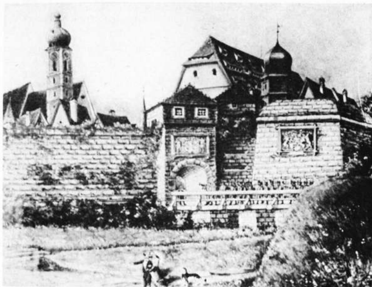
Das einstige Sattlertor, 1578/79 erbaut, mit der 2. altitalienischen Bastion von 1561/62, die als Staatseigentum vor Zerstörung bewahrt blieb. Besonders die von Michael Kotz im Bilde festgehaltene ehemalige Partie am Sattlertor zeigt das prächtige, eindrucksvolle Stadtbild, das die Festungswerke zusammen mit anderen Gebäuden der Stadt (dem bischöflichen Schloß rechts und der St. Martinskirche links) ergaben
