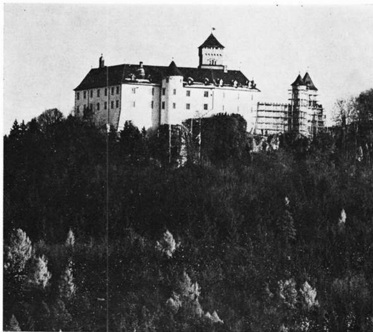
Burg Greifenstein, neueste Aufnahme nach dem Abbau des Gerüstes. Foto: Grün, Gößweinstein
