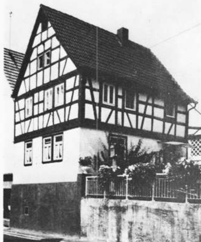
Erhaltung und Pflege der ursprünglichen Bausubstanz in der Hauptstraße von Hösbach
