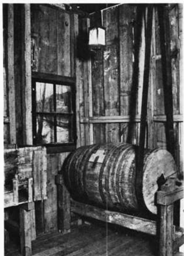
Die wieder erstandene Märbelmühle im Natur-Museum Coburg: Das Polierfaß in der Fensterecke mit dem Ausblick auf die Lauter
