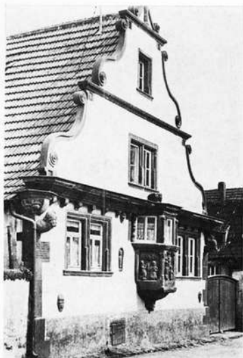
Das Apostelhaus in Gochsheim
