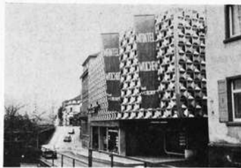
Wertheim: Mißglückt! Modernes Kaufhaus an der Tauber gegenüber der Altstadt. Fassade mit Aluminiumplatten verkleidet, die in ihrer Form Würfel vortäuschen. (Gegenstück zu Miltenberg).
