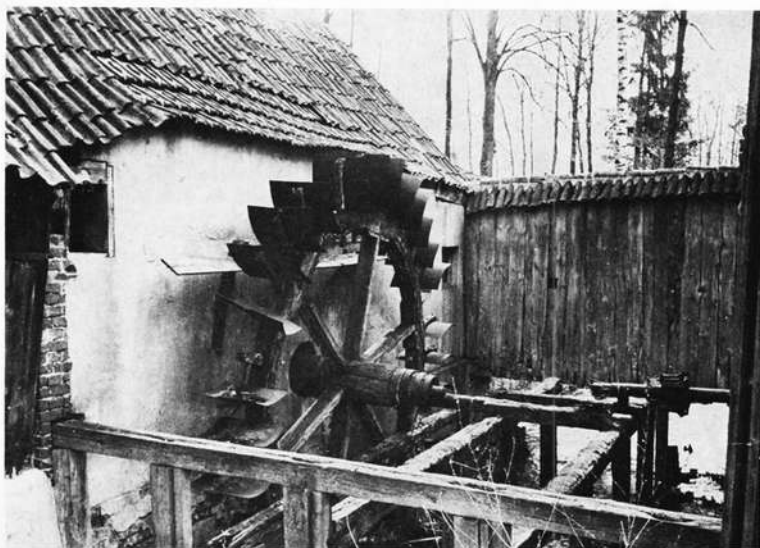
Die kümmerlichen Reste der letzten Märbelmühle in Oberlauter: das Wasserrad zum Antrieb der Mahlgänge. Inzwischen wurde das kleine Gebäude abgebrochen.
