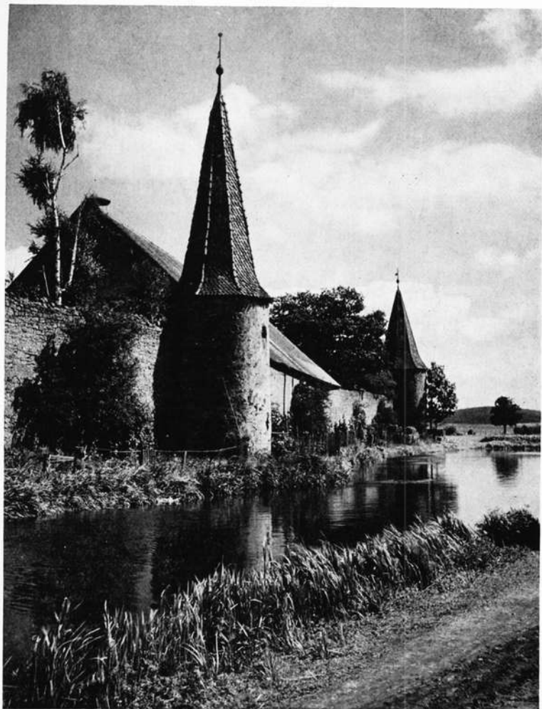
Merkendorf bei Ansbach: Östliche Stadtmauer. Obwohl allezeit von rein dörflicher Beschaffenheit, besitzt der Ort doch seit 1398 Stadtrecht. Damals ist auch die eigenwillig verlaufende Wehrmauer mit ihren hochbehelmten Rundtürmen entstanden, die sich bis heute ganz unversehrt erhalten haben. – Foto mit Erlaubnis des Verlages Hans Carl, Nürnberg, aus dem von Eugen Kusch aufgenommenen und beschriebenen Werk „Land der Franken“ veröffentlicht. Der 1961 herausgegebene Band zählt nach Inhalt und Ausstattung heute noch zu den schönsten Frankenbüchern.
