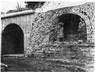
Restaurierungsmaßnahmen mit Selbstversorg, der mit Rankengewächsen bepflanzt wird
