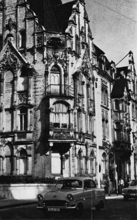
Mohrenstraße 9 a: In der Fassade vorgeblendeter Jugendstildekor neben baulichen Reminiszenzen an Gotik und Renaissance.
