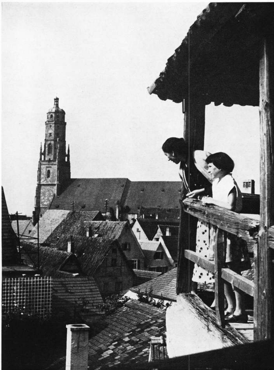
Nördlingen: Blick von der Stadtmauer auf die St. Georgskirche mit ihrem 90 m hohen Turm, dem „Daniel“ Foto: Holder, Urach/Württ.
