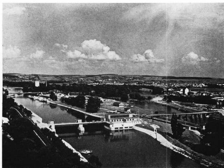
Mainausbau durch Schweinfurt. Staustufe mit Stauschützenwehr und Eltwerk. Im Hintergrund die neue Mainbrücke mit den Wehranlagen und Sicht auf Schloß Mainberg, Schonungen und Gärtnerdorf Sennfeld.
