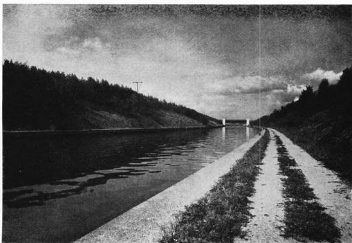
Durchstichkanal Volkach - Gerlachshausen, mit Hochwasser-Sperrtor. Aus der Aushubs-Erdmasse entstand westlich aus 3.300.000 cbm eine neue Anhöhe, die schön bewaldet ist.
