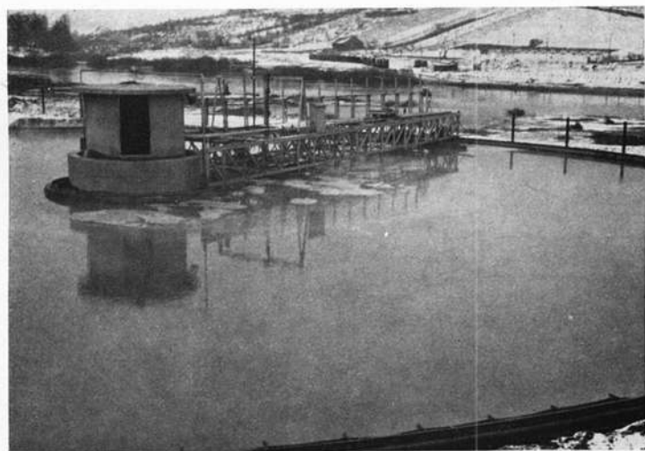
Zuckerfabrik Ochsenfurt. Absetzbecken zur Abwasserreinigung, Entschlammung. 2 Fotos: Dr. L. F. Schua/Würzburg
