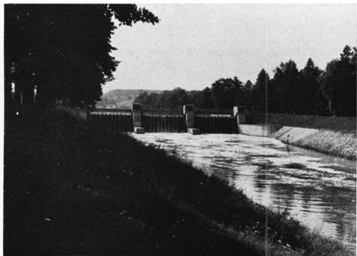
Hochwasser – Schützenwehranlage am rechten Regnitzarm im Hain in Bamberg. 4 Fotos: Martin Paulus/Bamberg
