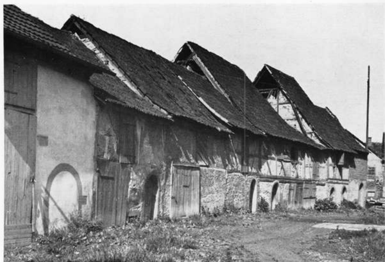
Abb. 2 Gaden (Kellerhäuser mit Fachwerkbau) der Kirchhofsbefestigung aus dem 16. Jh. von Geldersheim (Lkr. Schweinfurt). Aufn. H. Jäger
