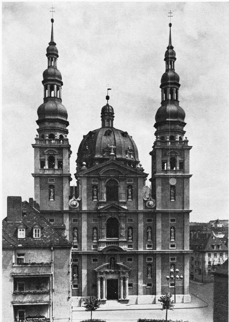
Stift Haug, die Fassade nach dem Wiederaufbau
