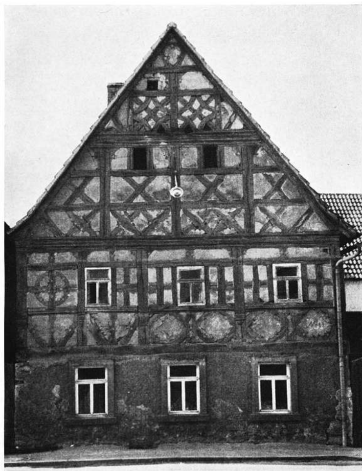
Römershofen Hs. Nr. 12, Landkr. Haßfurt. Bemerkenswert ist das hohe Alter des Fachwerks, das nach Eingravierung in einem Balken in das Jahr 1622 zu datieren ist. Liegende Rechtecke, mit Rauten, Viertelbogen und Andreaskreuzen gefüllt ergeben die starke Breitenwirkung, die durch die mächtigen Ständerbalken aufgefangen wird. 1963/64 abgerissen.
