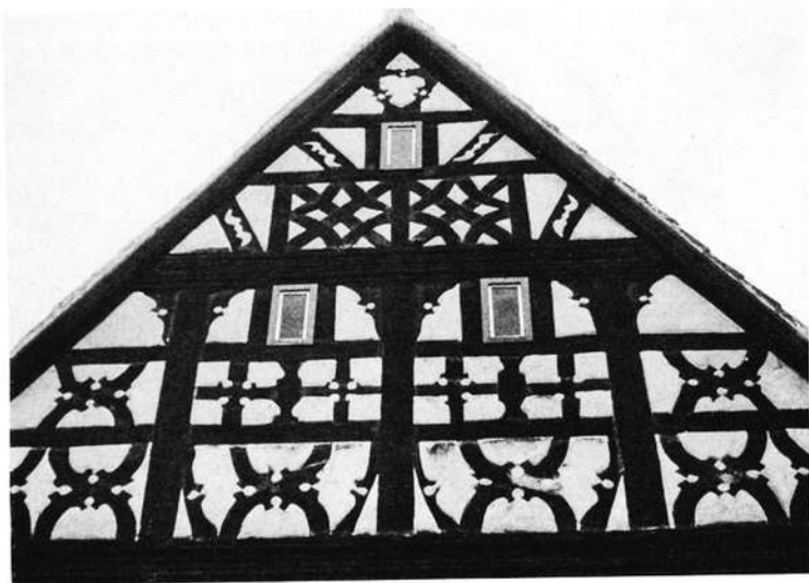
Giebfeld eines Bauernhauses in Hellingen, Landkr. Hofheim. Aus der Zweckform des Fachwerks entwickelte man eine Fülle künstlerischer Formen; gebogene Rauten mit Andreaskreuzen, Bogenkreuze mit seitlichen geschwungenen Ansätzen, sog. Näsen. Foto: Lamping
