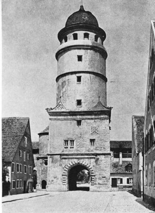
Nördlingen. Stadtbefestigung Löpsinger Tor, 1593 unter Mitwirkung Wolf Walbergers erbaut Foto: Bärenreiter- verlag, Kassel, Wilhelmshöhe
