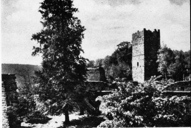
Ruine der Burg Wildenberg, einer Gründung der Edelherren von Dürn aus der Zeit um 1200. Wertvolles Beispiel für den Burgenbau aus der Stauferzeit. Die Burg wurde im Bauernkrieg zerstört.
