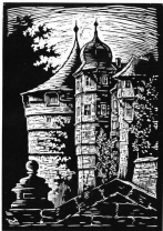
Feine Bauartung als Kreuzbau — Am Lagerhaus
