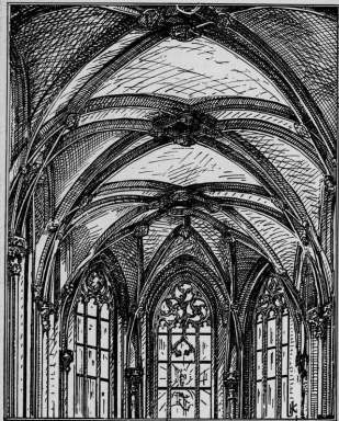
Teil des Chorgewölbes.
