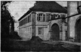
Röhrl'sche Wohnhaus in Ebern (jetzt Finanzamt)
